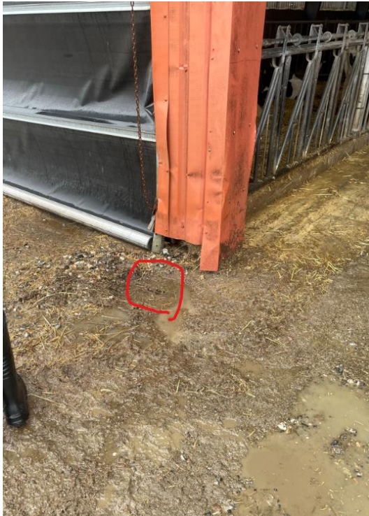
Udendørs afløb i enden af foderbord, kviestalden
