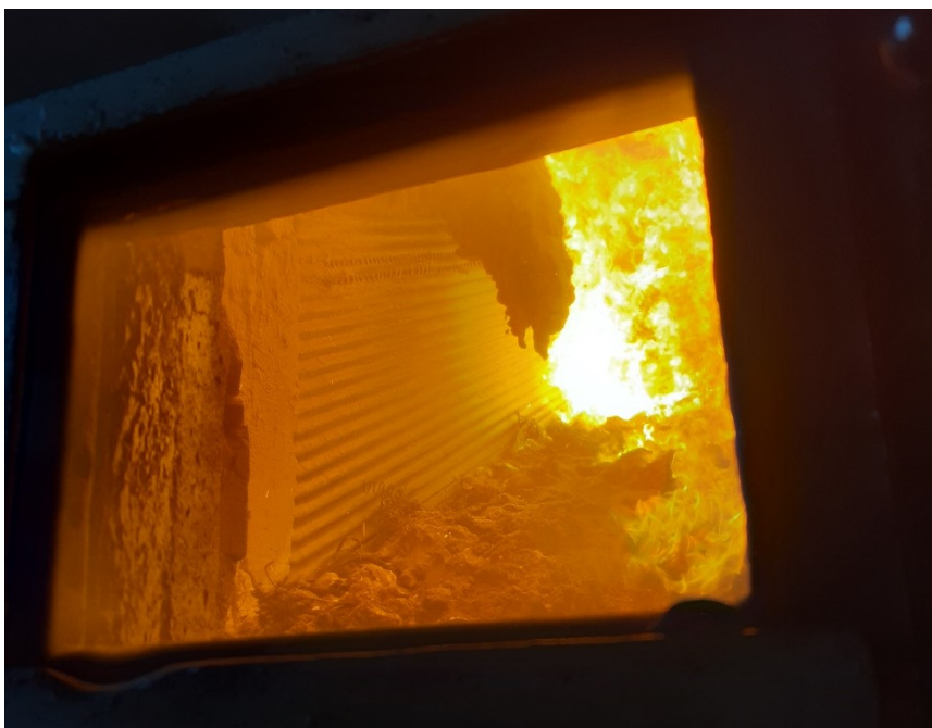
Ovnrum med synlig slaggeopbygning til venstre.
