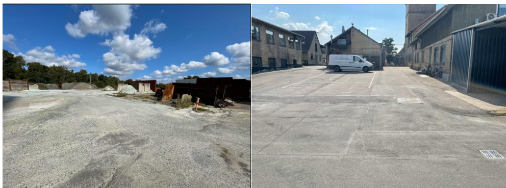
Billede 5: Vedligeholdte belægninger og nærmeste afløb (billede til højre).
