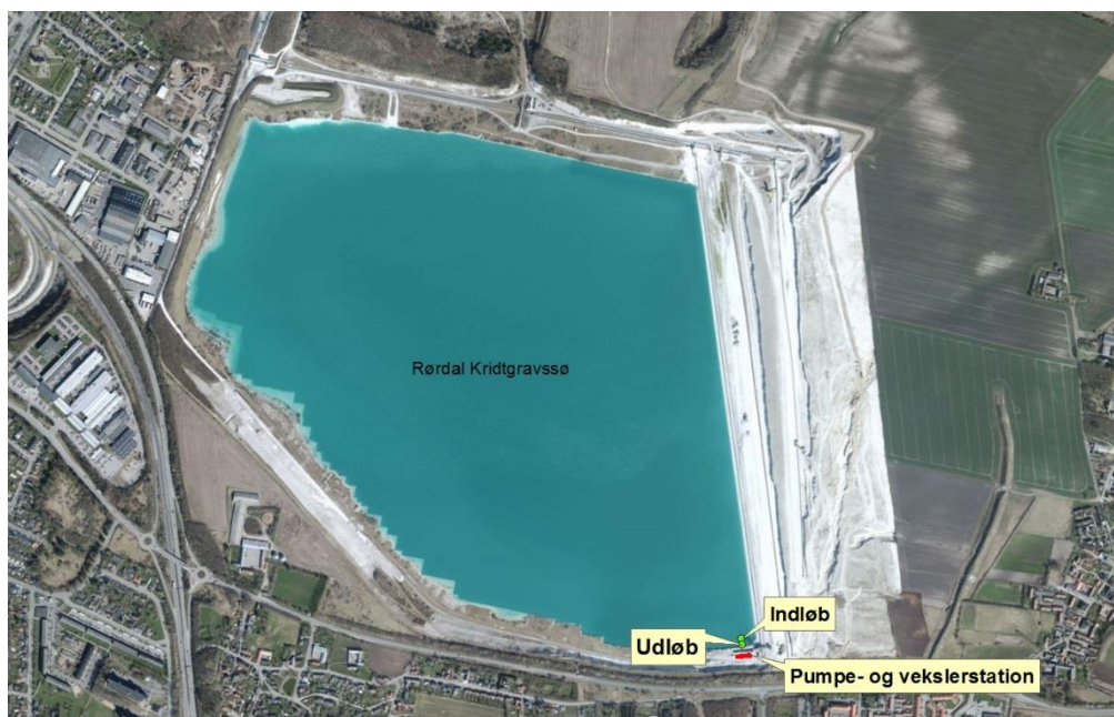
Figur 11: Luftfoto af Rørdals Kridtgravssø hvorfra der indvindes vand til fjernkøling. Området med placering af pumpe- og vekslerstation er markeret med rød firkant og der er markeret indtag og udløb af fjernkølingsvandet i søen.
