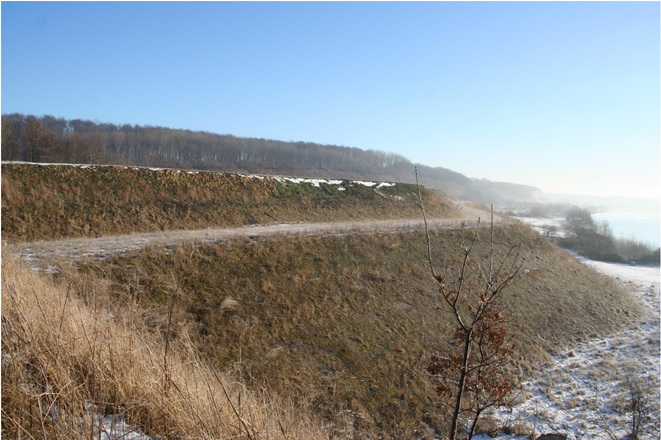
Figur 10. Etablering af Etage 2. Februar 2017.
