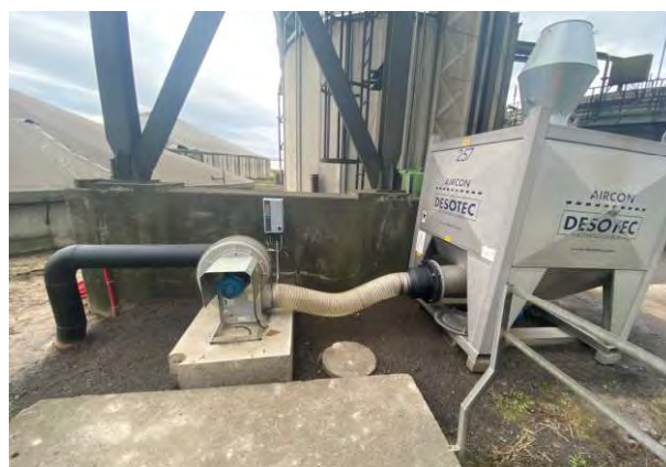
Nyetableret kulfilter og blæser
