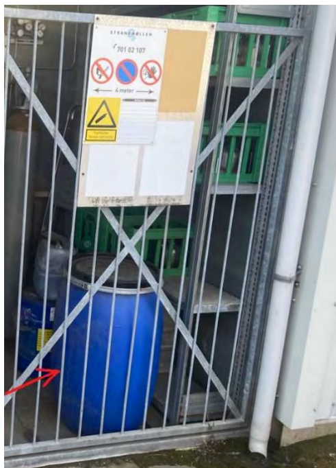
Figur 8. Farligt affald fra laboratoriet opbevares i det blå spændelågsfad. Fadet er placeret udendørs på fast underlag bag hegn. Når fadet er fyldt eller vejer max 25kg sendes det til destruktion ved Fortum.
