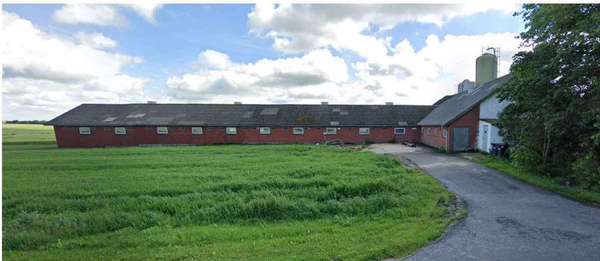
Husdyrbrugets placering i forhold til Hobrovej/ nærmeste nabo (google maps)
