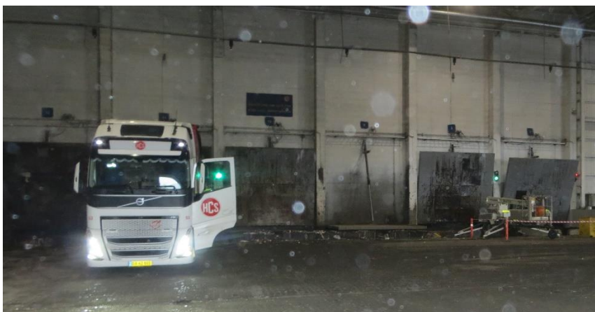
Luger på anlægslinje 6's affaldssilo. Hver luge kan åbnes for sig for aflæsning.
