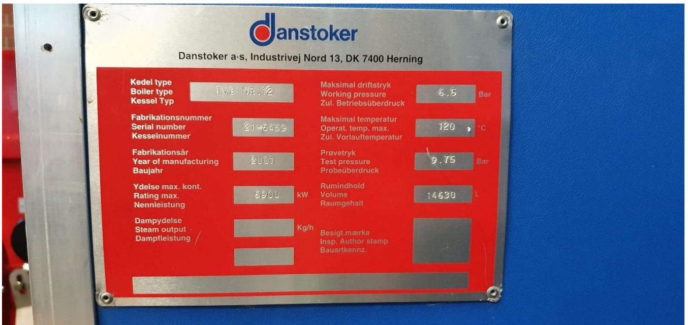
Kedel 2 - 5,9 MW fra 2001.
