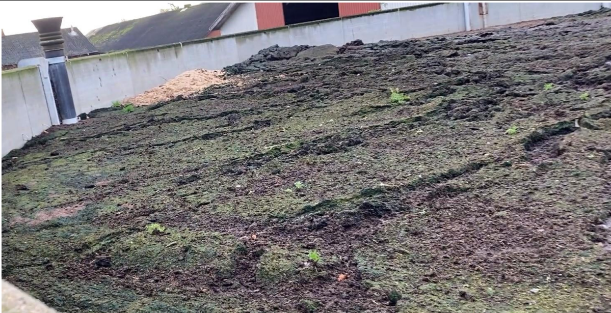
Gyllebeholder, dykket indløb
