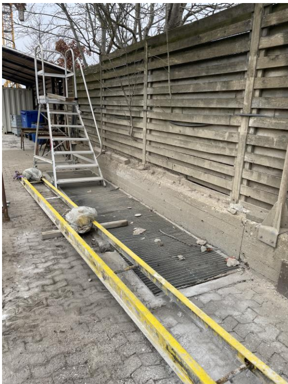
Billede 3. Vaskeplads med SF-sten
