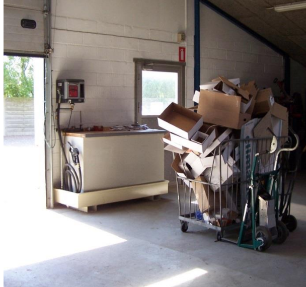
Firkantet dieselolietank anbragt i spildbakke placeret ved indgang til værkstedet. Forrest til højre en trådcontainer til papaffald
