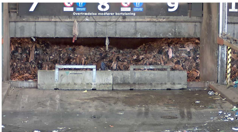
Betonklodser som vægge ind imod siloen.
