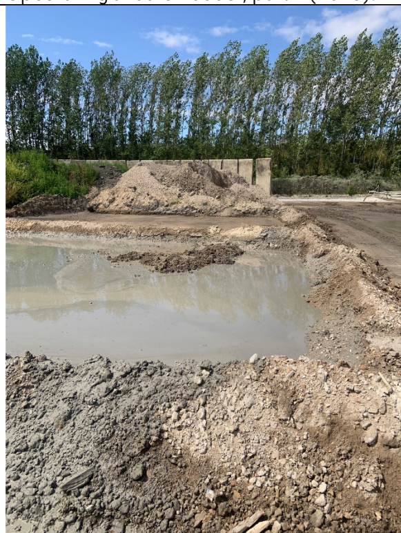
Celler til boremudder, port 4 (2023).
