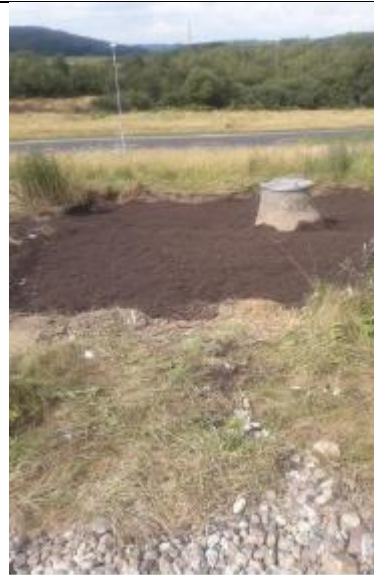
Færdigt biocover med kompost
