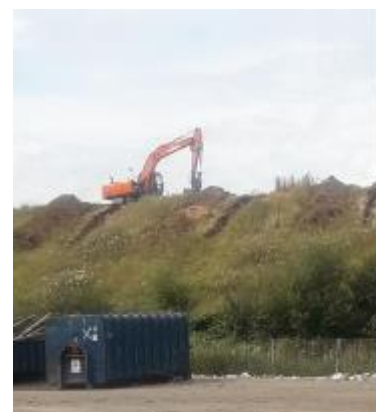
Etablering af skræntdræn
