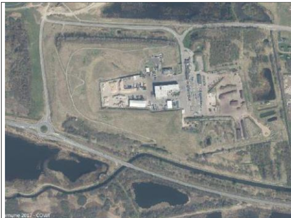
Vejle Genbrugsterminal. Deponeringsanlæg
