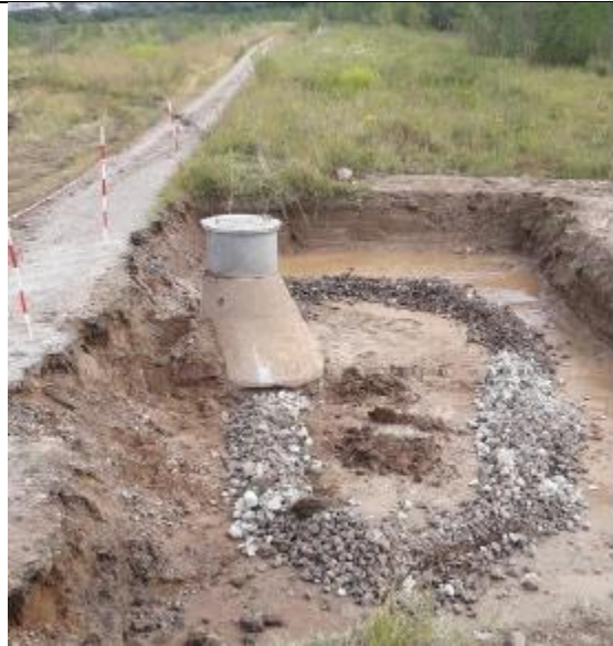
Biocover ved Brønd D7A under anlæg
