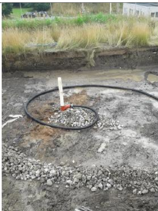
Dræn ved biocover, Boring B104
