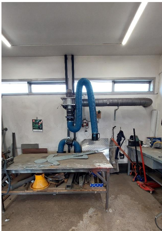
Billeder indefra og udefra, som viser at punktudsug ledes ud igennem væg og ikke op over tagryg.
