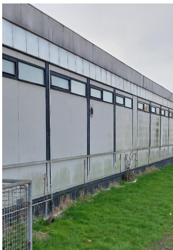
Billeder indefra og udefra, som viser at punktudsug ledes ud igennem væg og ikke op over tagryg.
