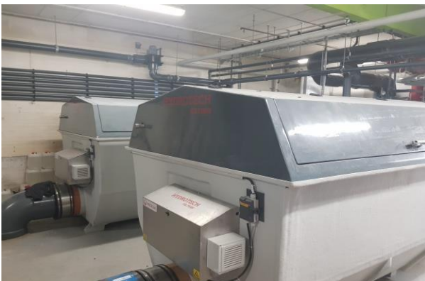
De 2 nye tromlefiltre til 50 meter bassinet
