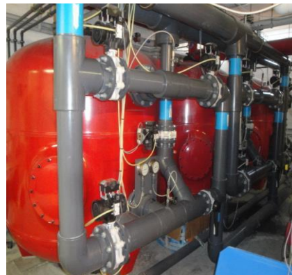
Sandfiltrene, varmtvandsbassin
