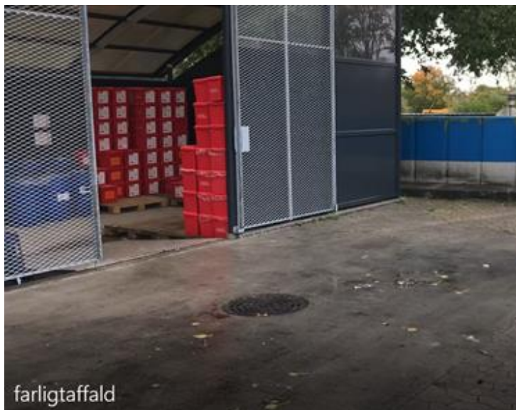
Udendørs areal med afløb ved Byttehuset
