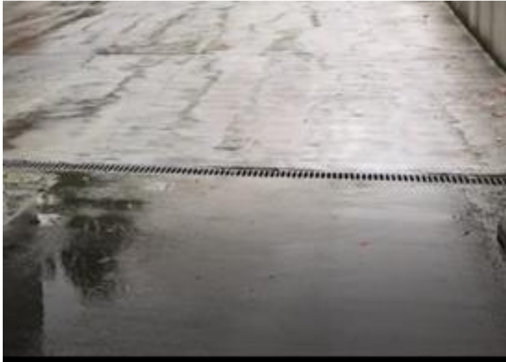
Rampe ned til transportcontainer
