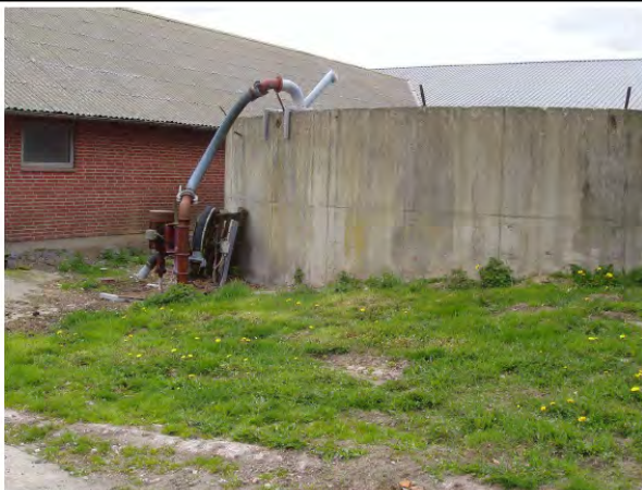
Beton gyllebeholder på 500 m 3 med fortank
