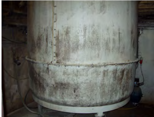
I bygning 3 foderlade er der placeret en hvid glasfibertank til foder
