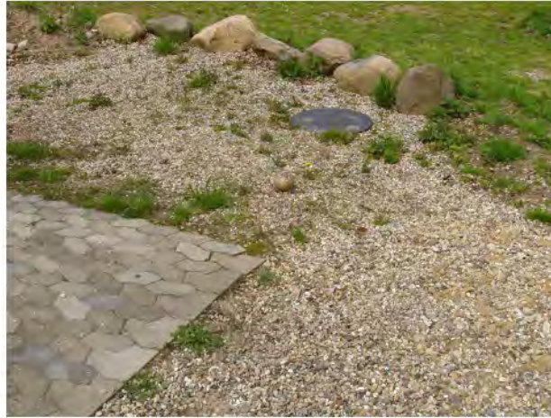
Ved gavlen af stuehuset er der placeret en septiktank til stuehusets sanitære spildevand
