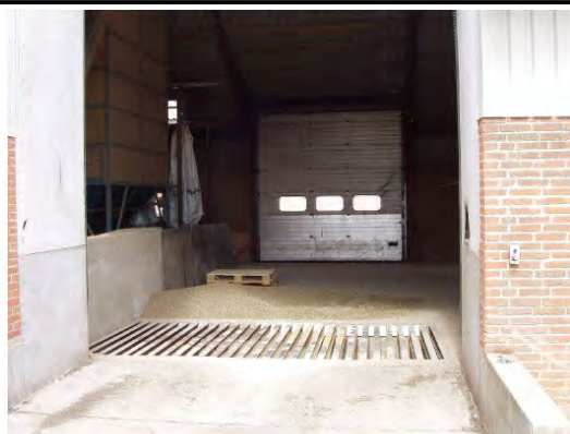
I bygning 3 foderlade er der en korngrav til diverse råvarer.
