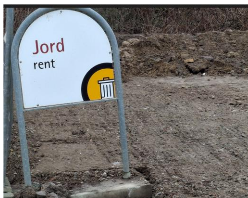
Foto 10. Skiltning af oplag af ren jord til daglig afdækning/slutafdekning
