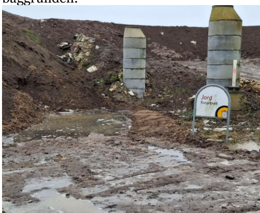
Foto 5. Celle til forurenede jord. Forhøjede perkolatbrønde og dermed er cellen klar til yderligere deponering.
