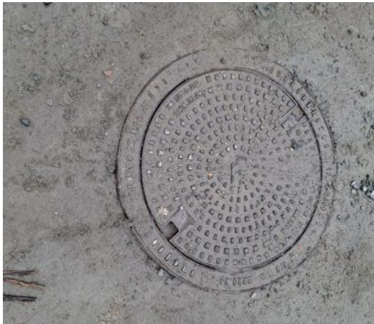
Foto 14. Dæksel til grundvandsmoniteringsboring OBS6
