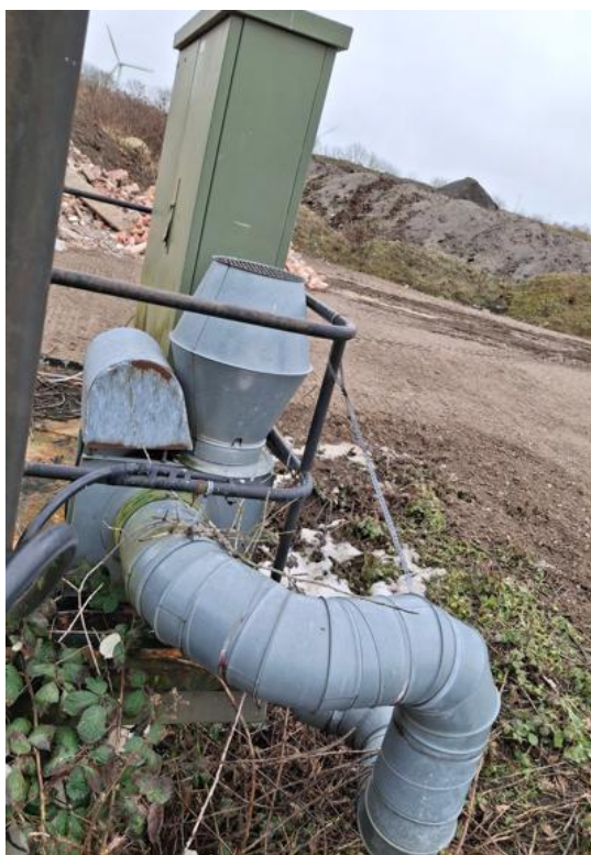
Foto 18. Perkolatpumpe med tilhørende elektronikhus på gl. losseplads
