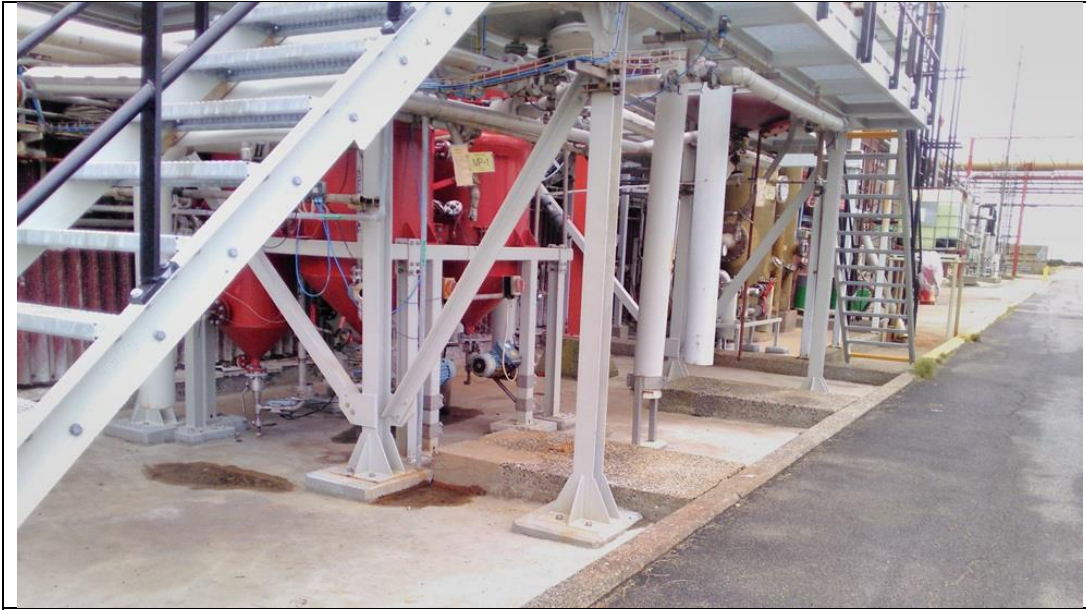
Tankgrav ved P1-anlægget fremstod pæn og tæt – mindre vandpytter skyldes regn samme morgen.
