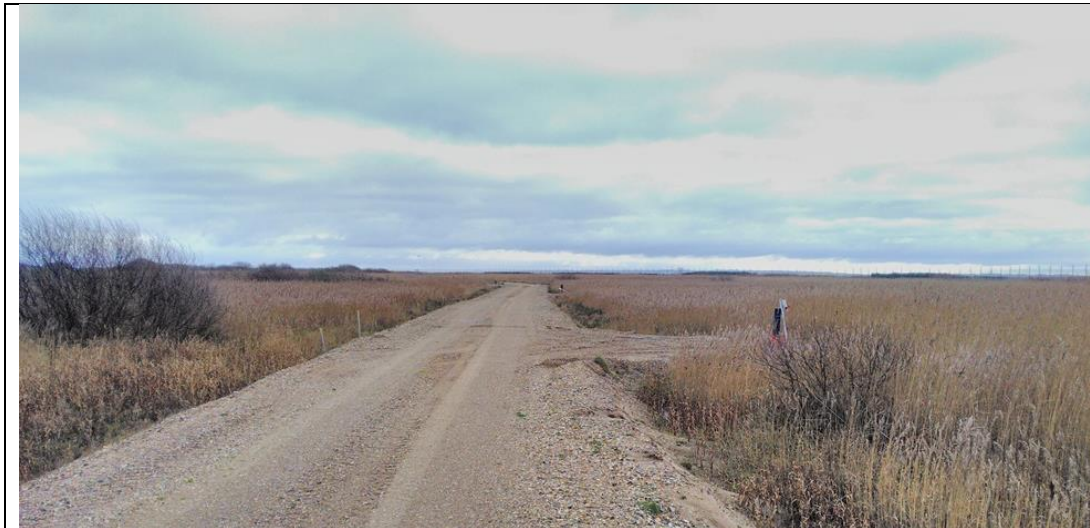
Forstærket grusvej og nye pumpestationer i Sydområdet.
