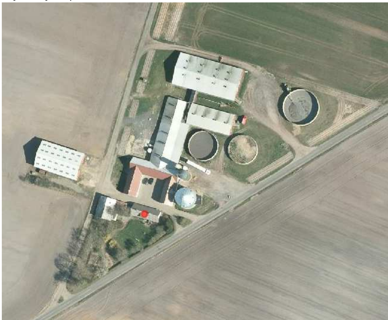
Bilag 1: Oversigt over ejendommen
