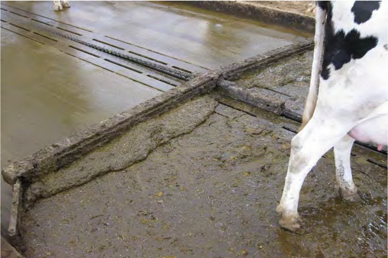
Billede 4. Stationær skraber med vinkling, der bevirker, at gødningen hurtigt forsvinder.
