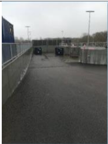
Foto ned i graven på omlastepladsen
