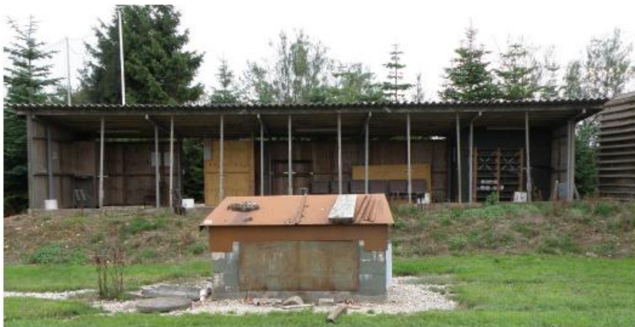
Figur 3. Type Z, støjisoleret skydehus på en sportingbane. Skydehuset vil være med frembygger sidevægge på venstre side, minimum 5 meter fra geværmunding (D-arkiv foto).
