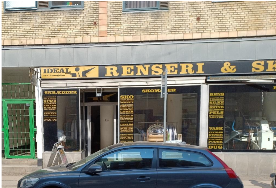
Figur 1: Renseriet er beliggende i stueetagen i en boligejendom på Borgergade.
