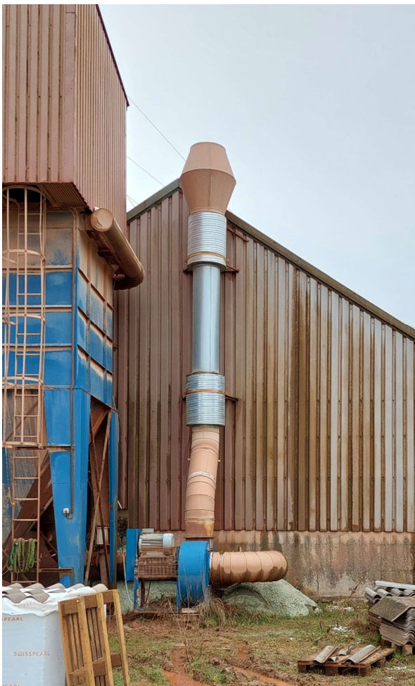
Billede 4. To støjfiltre på jethætte
