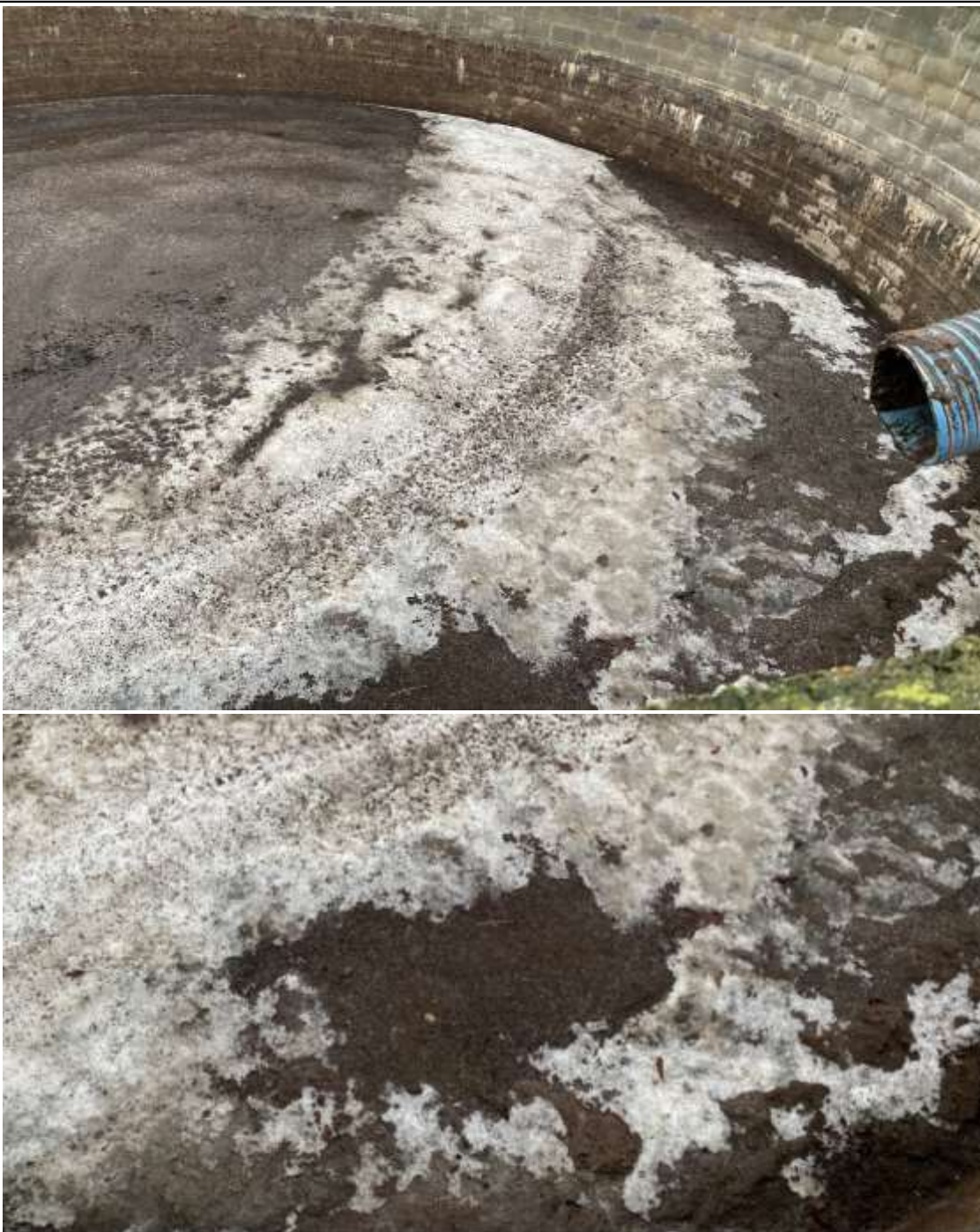
Gyllebeholder, tilstand og bevoksning
