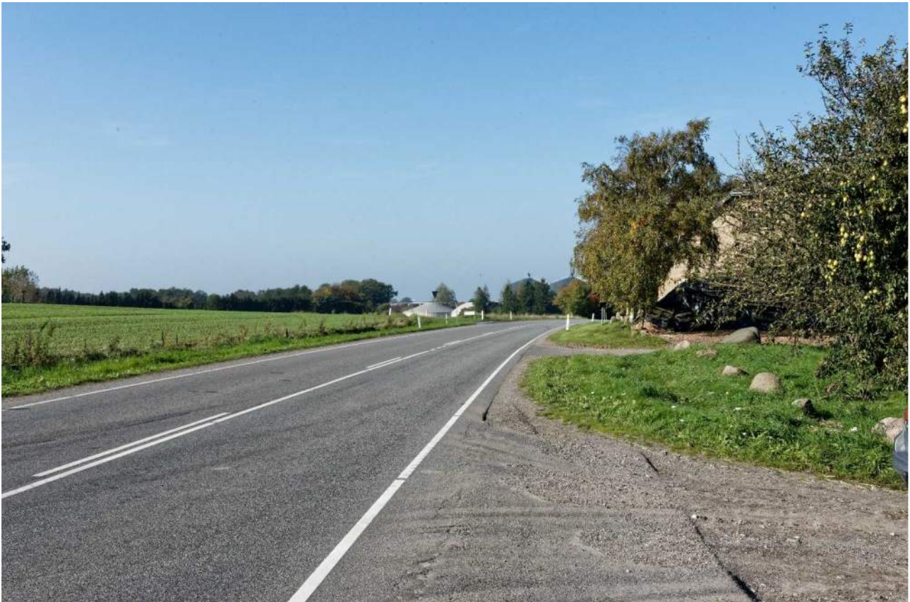
Figur 9.7: Standpunkt 3. I dag er de lave tanke på det eksisterende anlæg synlige fra Odensevej sydøst for anlægget på grund af hullet i bevoksningen, mens de høje tanke er næsten skjult.
