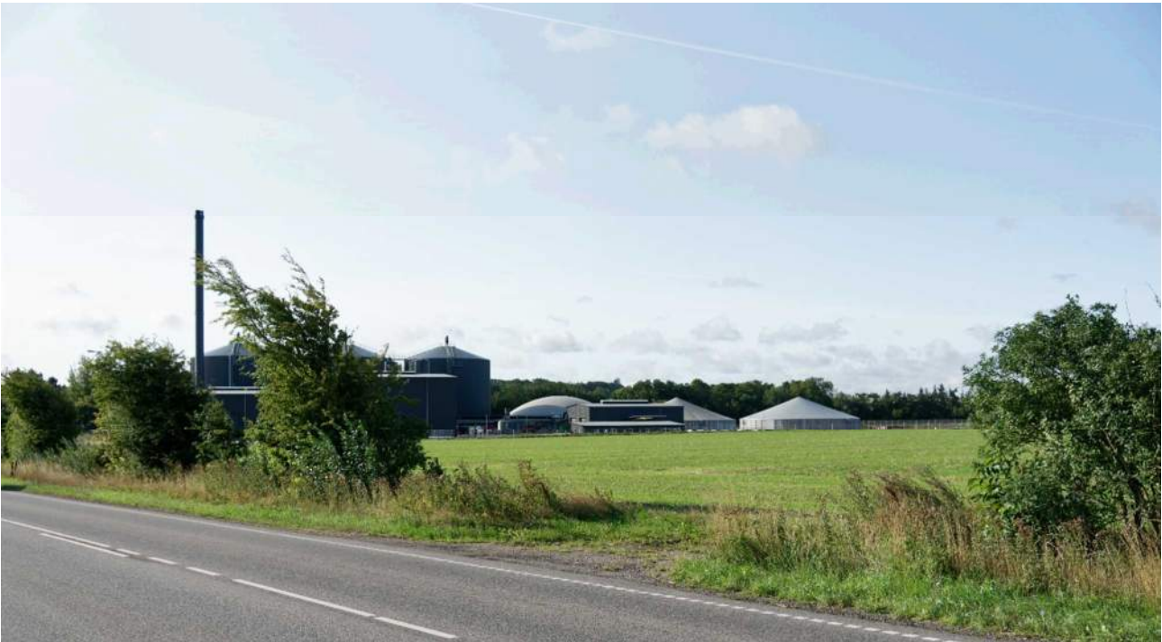
Figur 9.5: Standpunkt 4. Indkig til det eksisterende anlæg fra nord set fra Odensevej.
