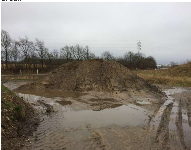
Forurenede jord fra Tømrervej 8 opbevaret på ubefæstet areal.
