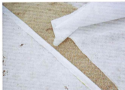
Endnu et lag af 50 cm vandbehandlingskalk.
