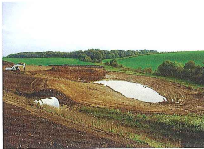
Udgravet bassin med lermembran.
