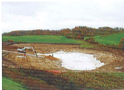
Fibertextdug og 20 cm 0/4 mm drængrus (bygherreleverance).
