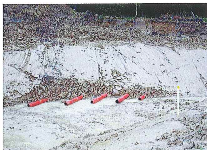
Bassin med lermembran og drænrør.
