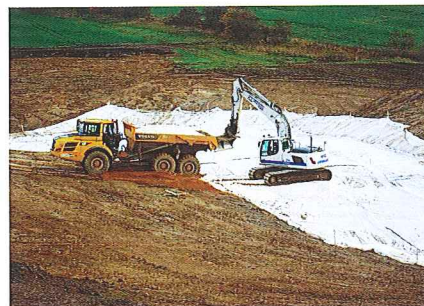
Fibertextdug og 20 cm vandbehandlingskalk (bygherreleverance).
