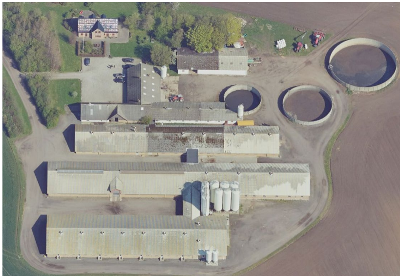
Figur 1 Højrupvej 37 set fra syd. Kilde Skråfoto.dk
