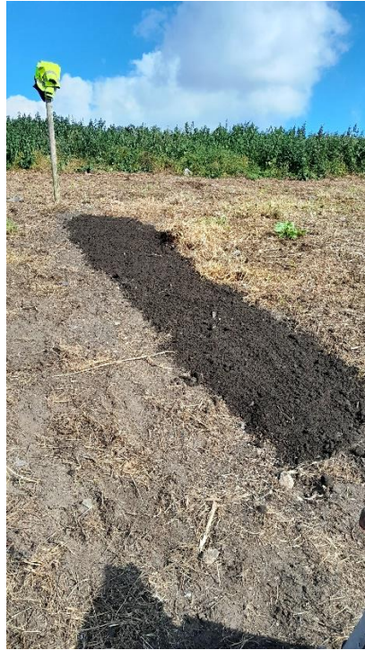
Figur 7 På billede til venstre ses, at bevoksning er fjernet på biocover V6, og til højre ses, at der er sket efterfyldning med kompost.
