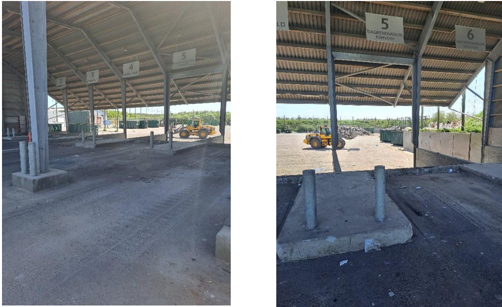
Figur 1 Omlastestation for dagrenovation. Ved tilsynet fremstod anlægget ryddeligt.
