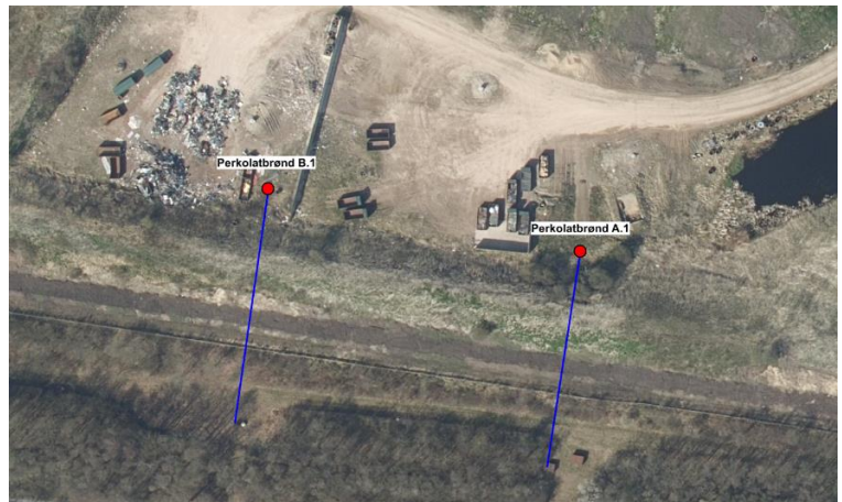
Figur 6 Placering af perkolatbrønde og ledninger (ORTHO foto er taget inden oplag er fjernet)
