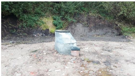
Figur 5 Perkolatbrønd mod syd, der blev kontrolleret ved tilsynet.
