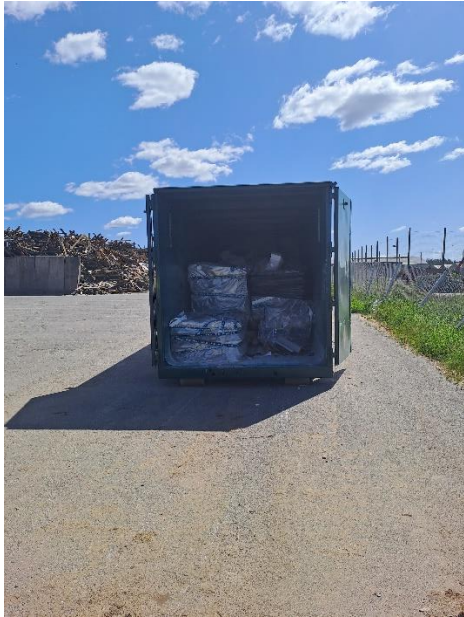
Figur 3 På fast belægning er oplag af ikke neddelte træaffald, og container til asbestaffald
