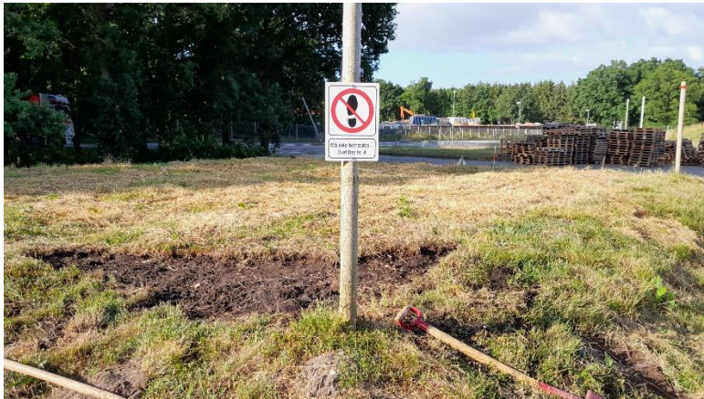
Figur 7 På billede til venstre ses, at bevoksning er fjernet på biocover V6, og til højre ses, at der er sket efterfyldning med kompost.
