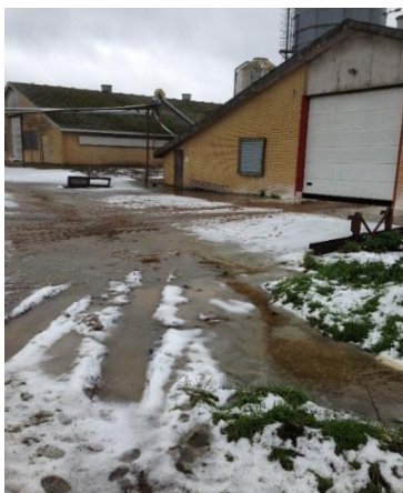
Forplads hus 3, det ses hvor væske løbet til ubefæstet areal.
