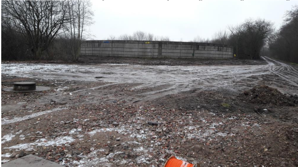
Fig. 11. Bobøl Deponi. Bufferbassin til perkolat, 2500 m 3 .
