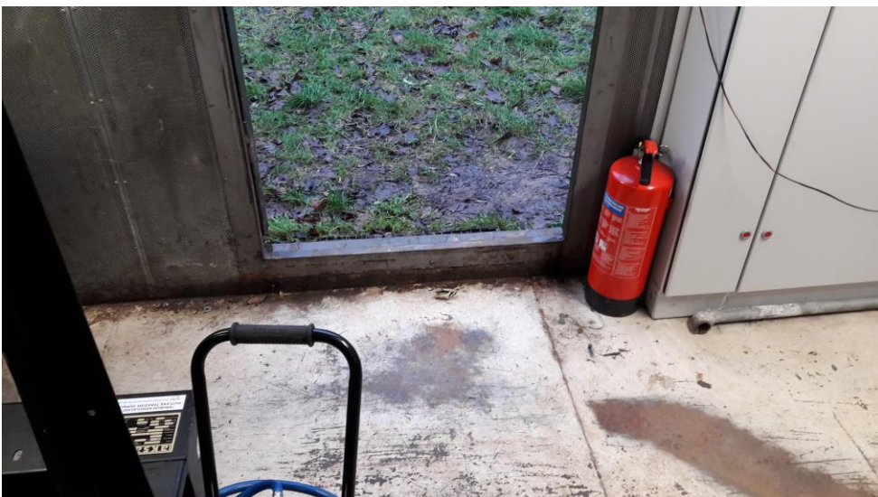
Fig. 7. Bobøl Deponi. Der er 10-15 cm opkant i containeren.
