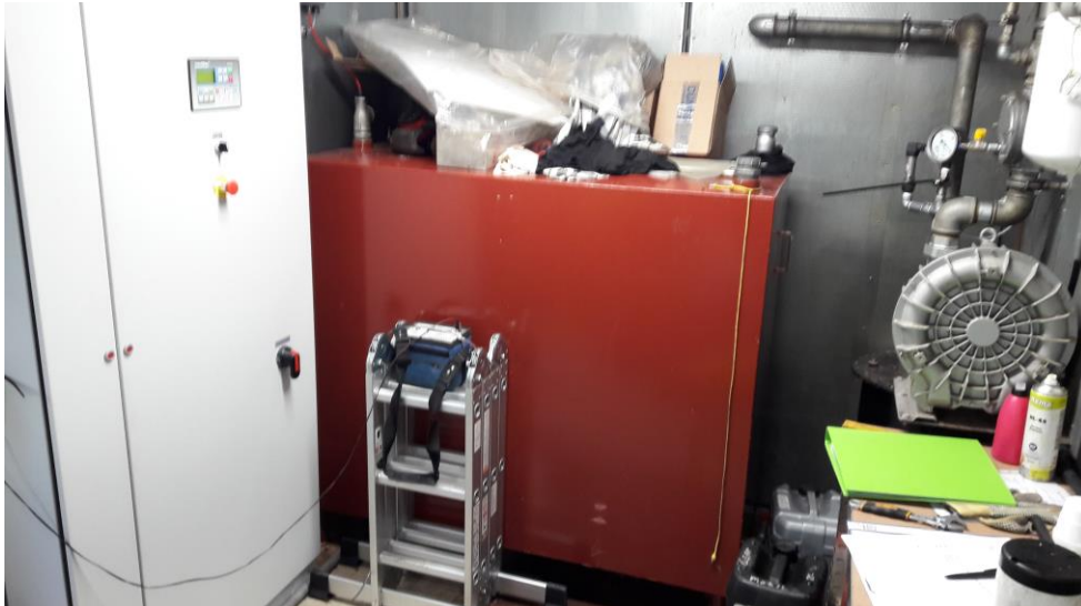
Fig. 14. Bobøl Deponi. Overjordisk olietank i gascontainer.
