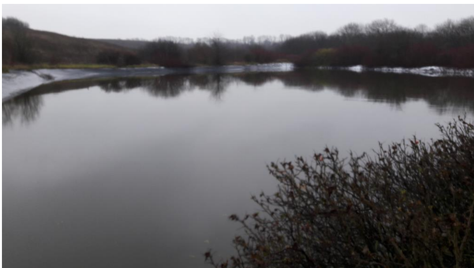
Fig. 9. Bobøl Deponi. Perkolatlagune til spidsbelastningssituationer.
