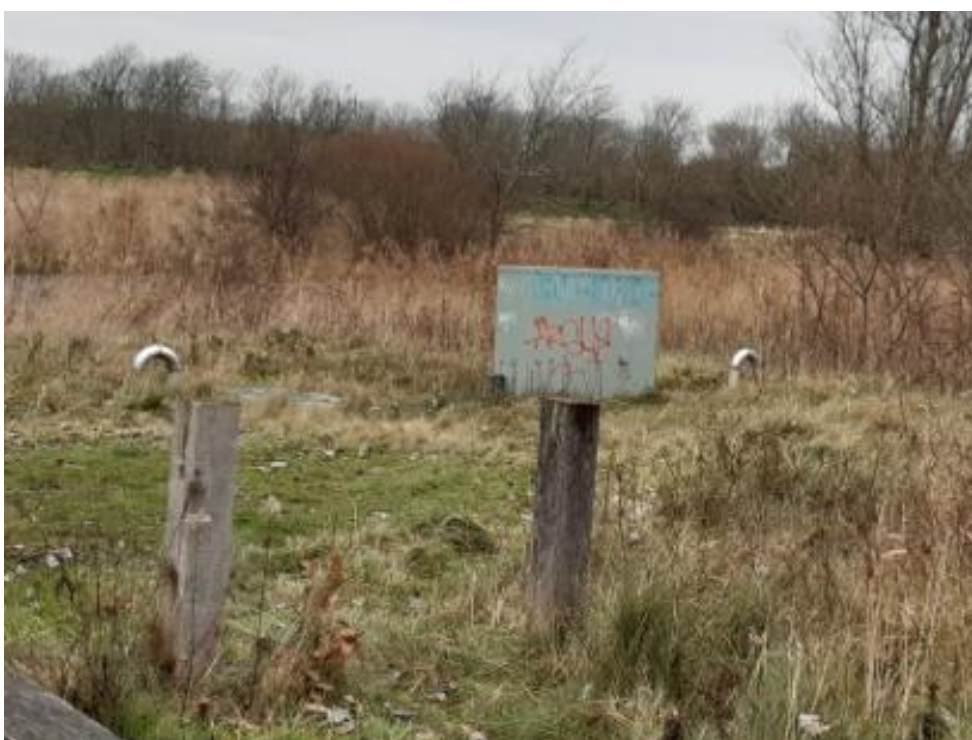
Den nordlige pumpestation
