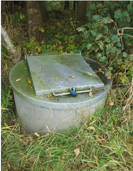
Billede 5 Alle opstrøms boringer havde betonring til beskyttelse mod påkørsel, og aflåst låge. Boringerne er også mærket med vandtæt mærke, hvor DGU nummer er angivet.
