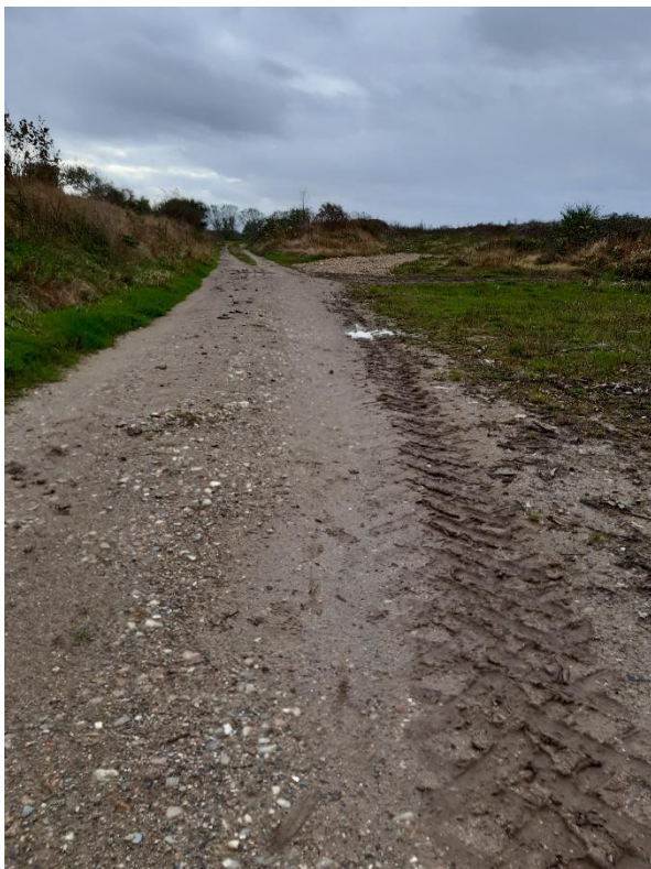
Billede 4 grusstiger anlagt til køretøjer oven på arealet med deponering.
