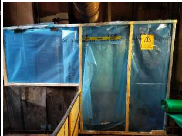
Tank med asbest samt asbestsluse til tilsvarende tank med asbest på Zafiro Producer.
