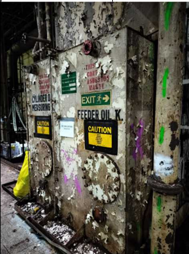
Tank med asbest samt asbestsluse til tilsvarende tank med asbest på Zafiro Producer.
