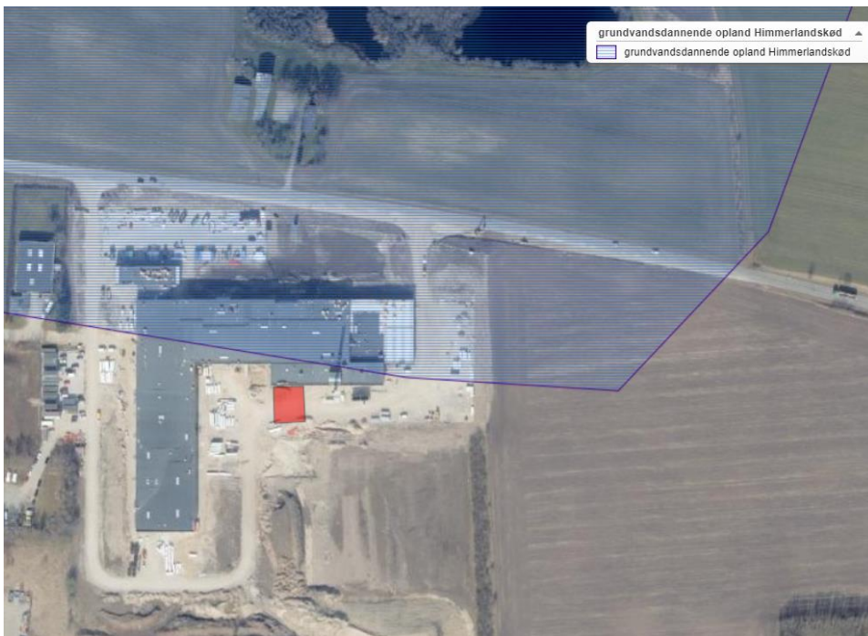
Billede 3: Luftfoto med markering af udbredelsen af det grundvandsdannende opland, og placering af belægning (rød markering) uden for biproduktrum.
