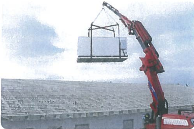
Modul sættes på plads med kran
