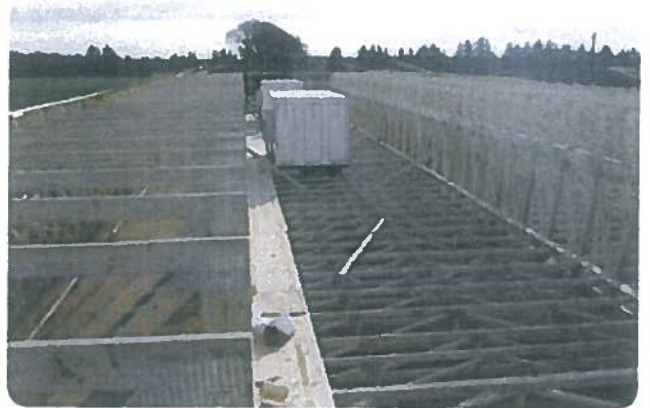
Modul indsat på loft
