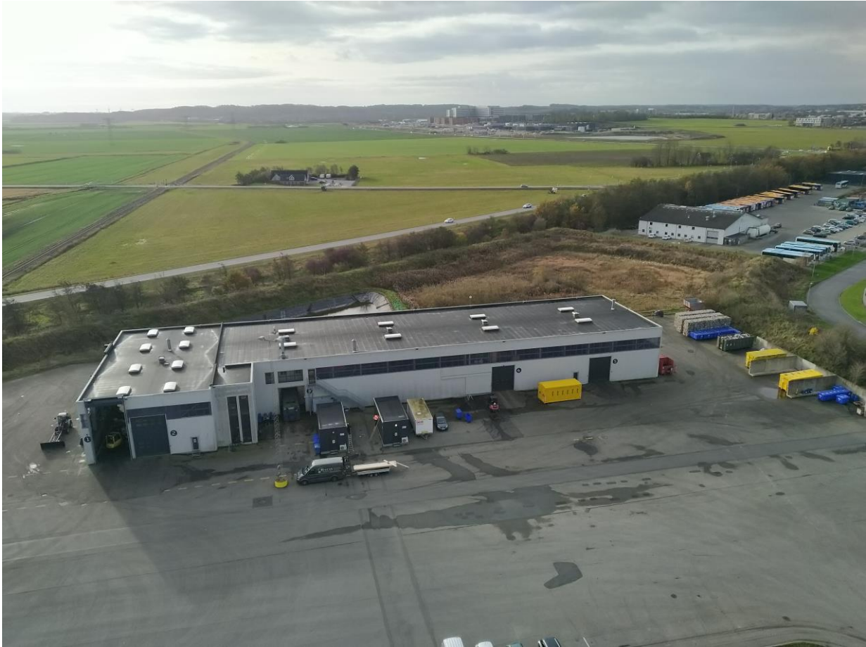
Oversigtsbillede af sorteringsanlæg for plast og metal
