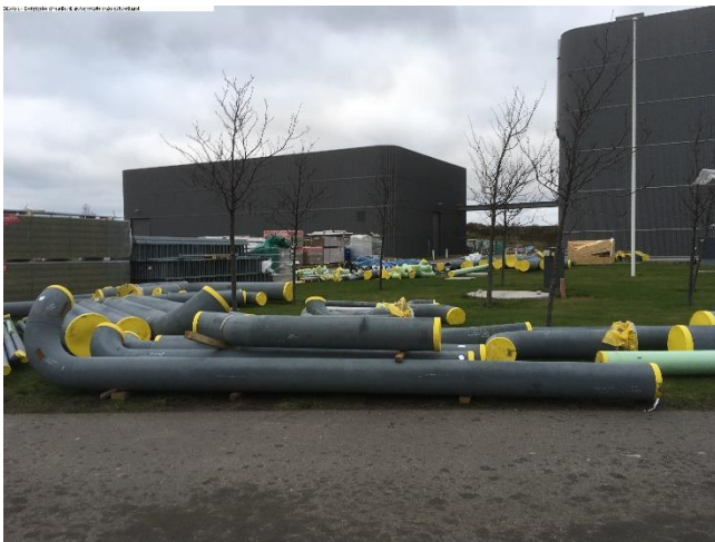
Billede 2a og 2b – Besigtigelse af udendørs arealer med midlertidig opbevaring af byggemateriale
