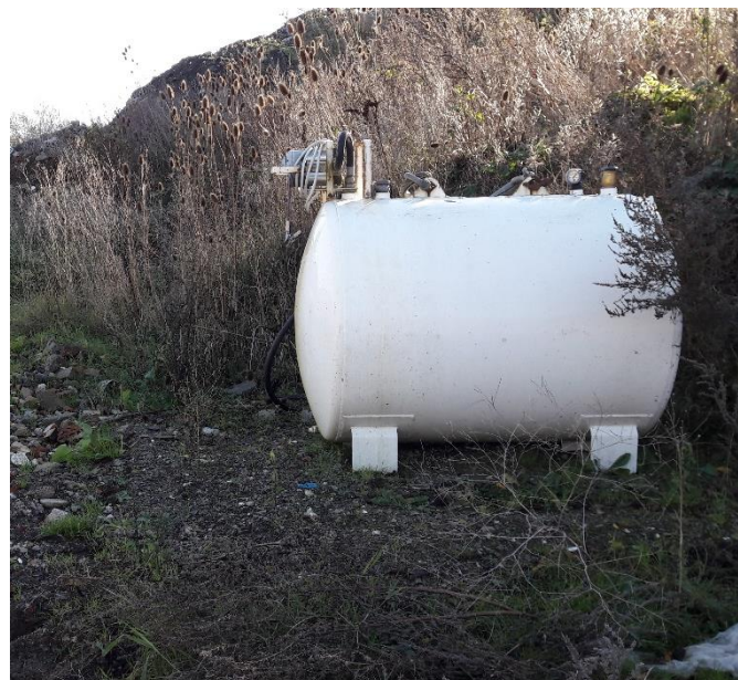
Figur 8. Olietanke. 1) Dieseltank til påfyldning af diverse maskiner. 2) Aftapningshane. 3) Mobil tank på etape 6 til brug for kompaktorer.
