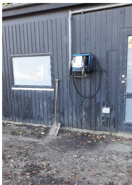
Figur 8. Olietanke. 1) Dieseltank til påfyldning af diverse maskiner. 2) Aftapningshane. 3) Mobil tank på etape 6 til brug for kompaktorer.
