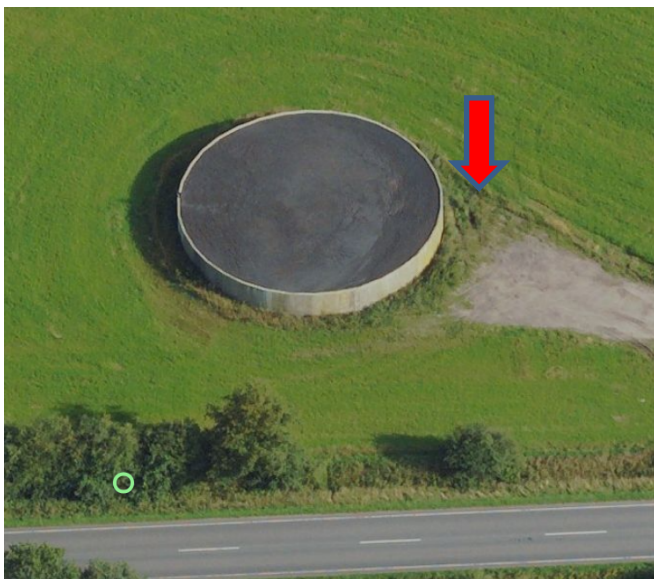
Fig.: Ny buffertank, se under rød pil.
