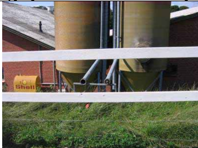
Bygning nr. 10a Anvendelse: Færdigfoder siloer
