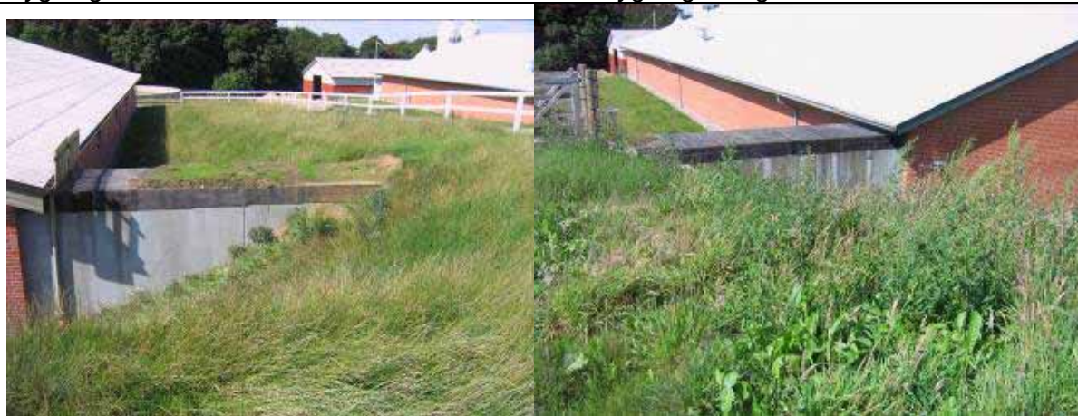
Bygning nr. Anvendelse: Tunnel mellem bygning 10 og 11
