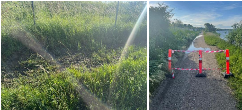
Synligt vandmættet dige, afspærring og vand på sti
