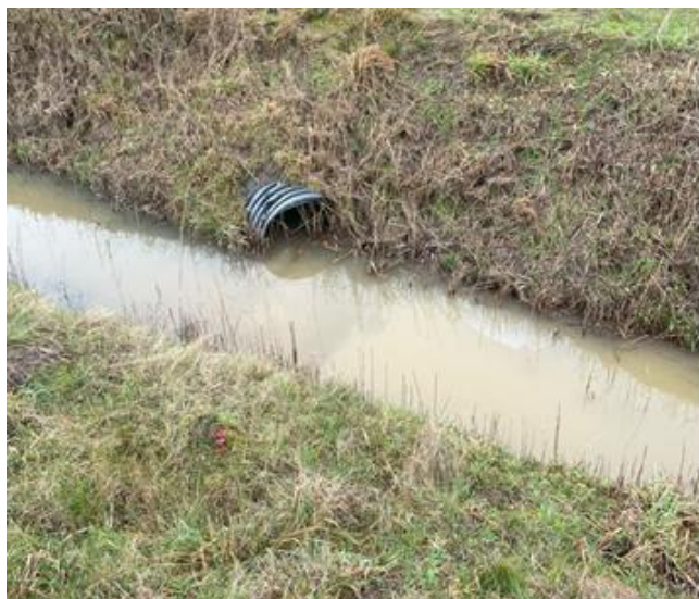
Foto 17. januar 2023. Udløb af den nord-syd grøft til "vadehavsgrøften". I ugen op til er faldet megen nedbør.
