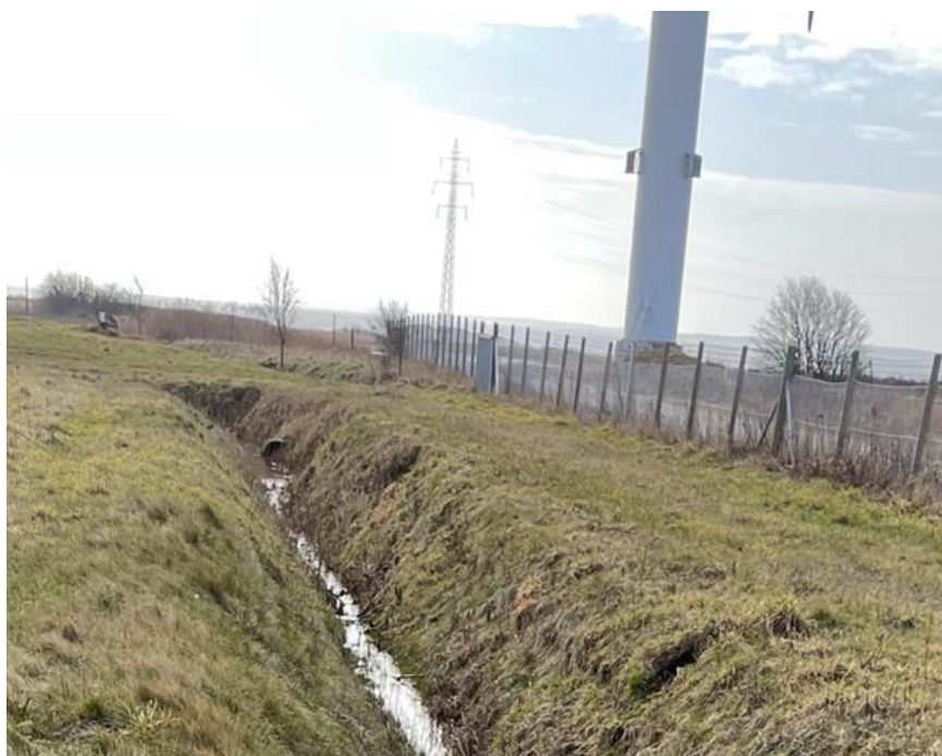
Foto 9. februar 2023. Udløb af den nord-syd grøft til "vadehavsgrøften". I ugen op til er der ikke faldet megen nedbør.
