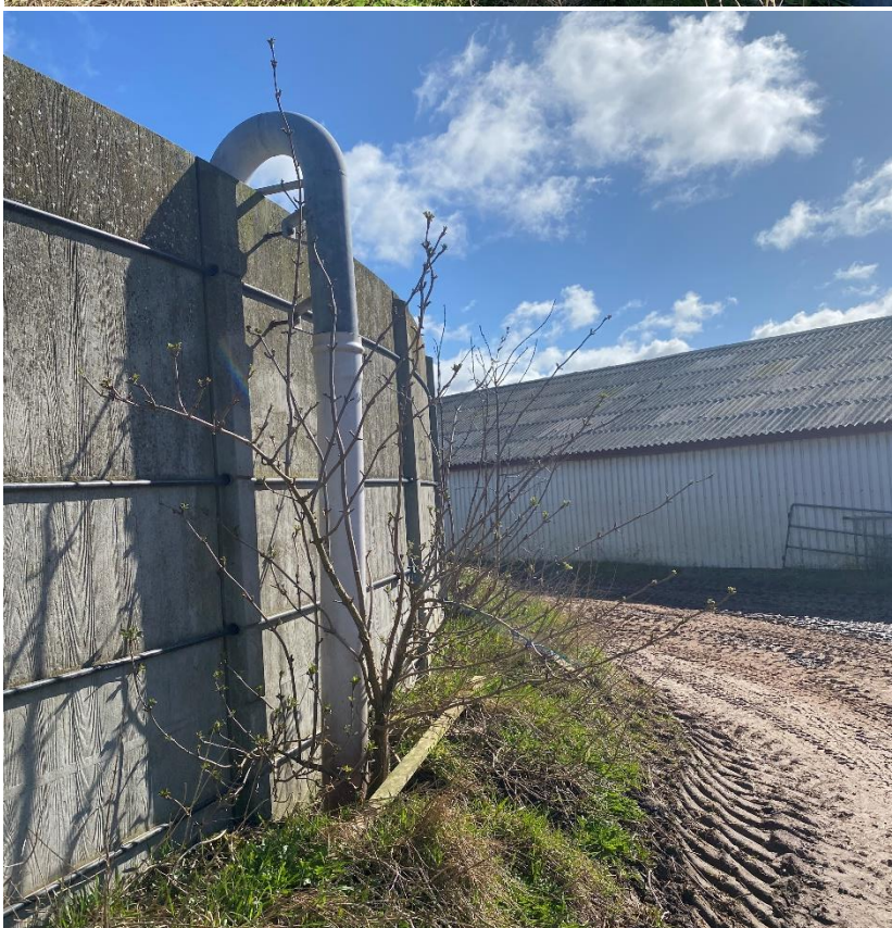
Gyllebeholder, tilstand og bevoksning
