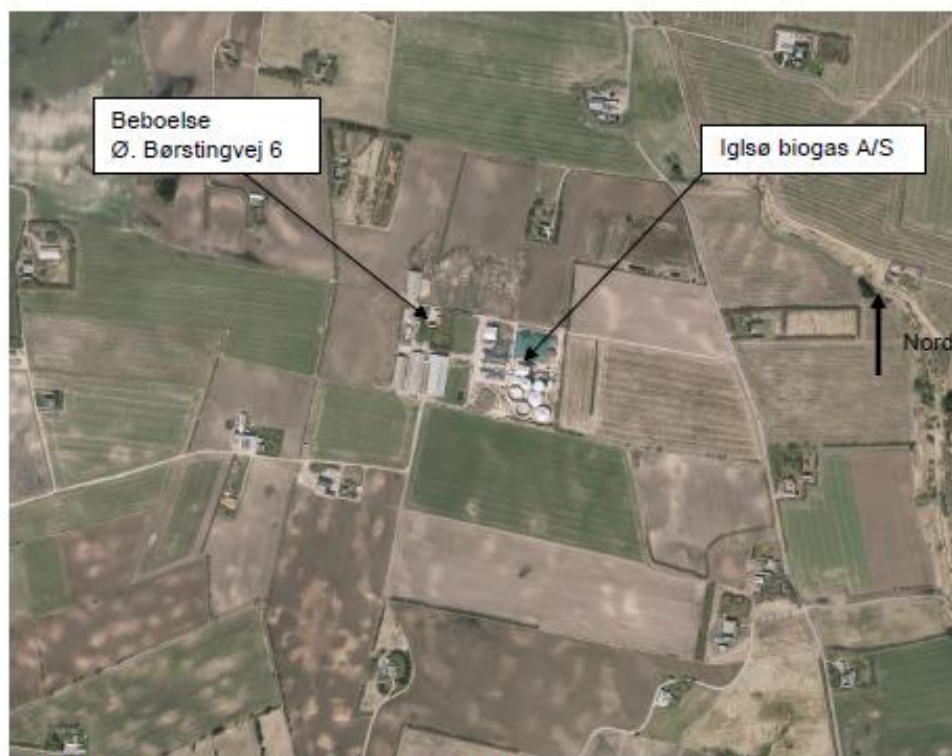
Figur 1. Iglsø Biogas og nærmeste naboer. Ikke i mål
