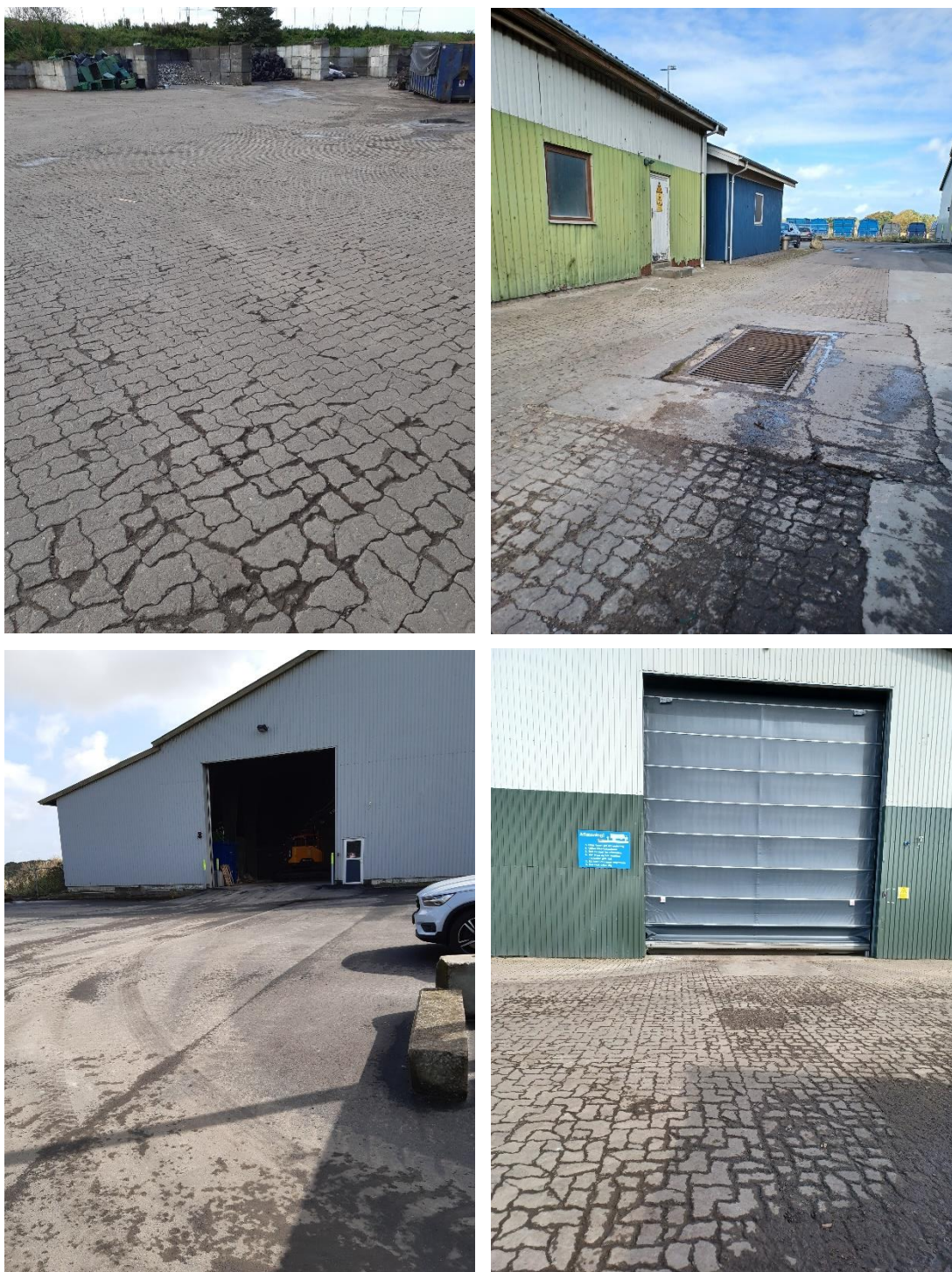
Figur 4. Belægninger. Øverst tv: Belægningen på omlastepladsen. Øverst th: Belægningen ved vaskepladsen. Der er blevet etableret en helstøbt belægning mellem vaskepladsen og den vestlige port til den gamle omlastehal (til højre i billedet). Nederst tv: Ny asfaltbelægning udenfor den nye omlastehal (nr. 1 på oversigtskort 2). Nederst th: Nedbrudt belægning udenfor den sydlige port til den gamle omlastehal (nr. 6 på oversigtskort 2).
