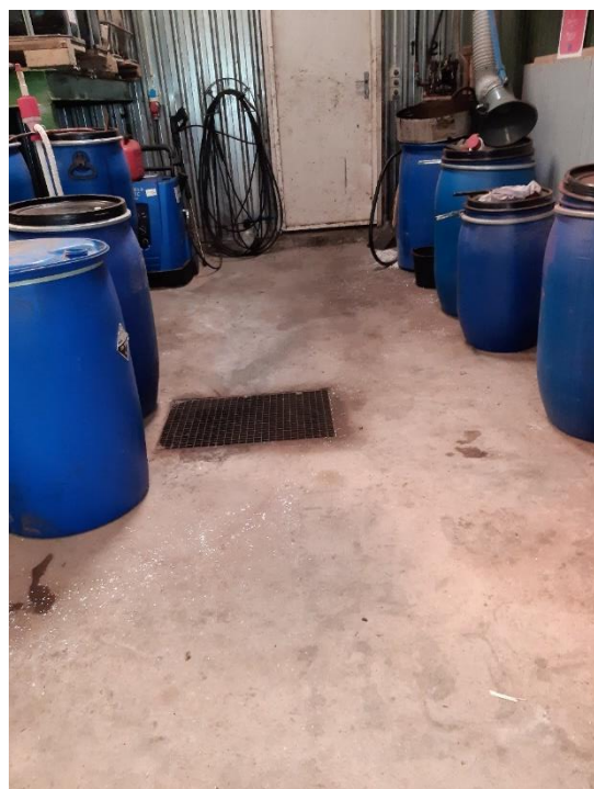
Figur 7. Oplag af olie og farligt affald. Øverst: Oplag af hydraulikolie i garage. Nederst tv: Rum til farligt affald med rist til sump midt i rummet. Nederst th: Væske i sump.
