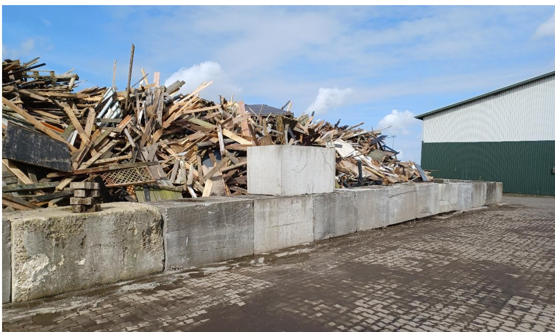
Figur 3. Omlasteplads. Øverst: Båse til forskellige affaldsfraktioner. Midterst: Oplag af træ. A4-træ til venstre, A2-træ til højre. Nederst: Betonklodser er sat op for at markere oplagsområder og holde affald inde på pladsen.
