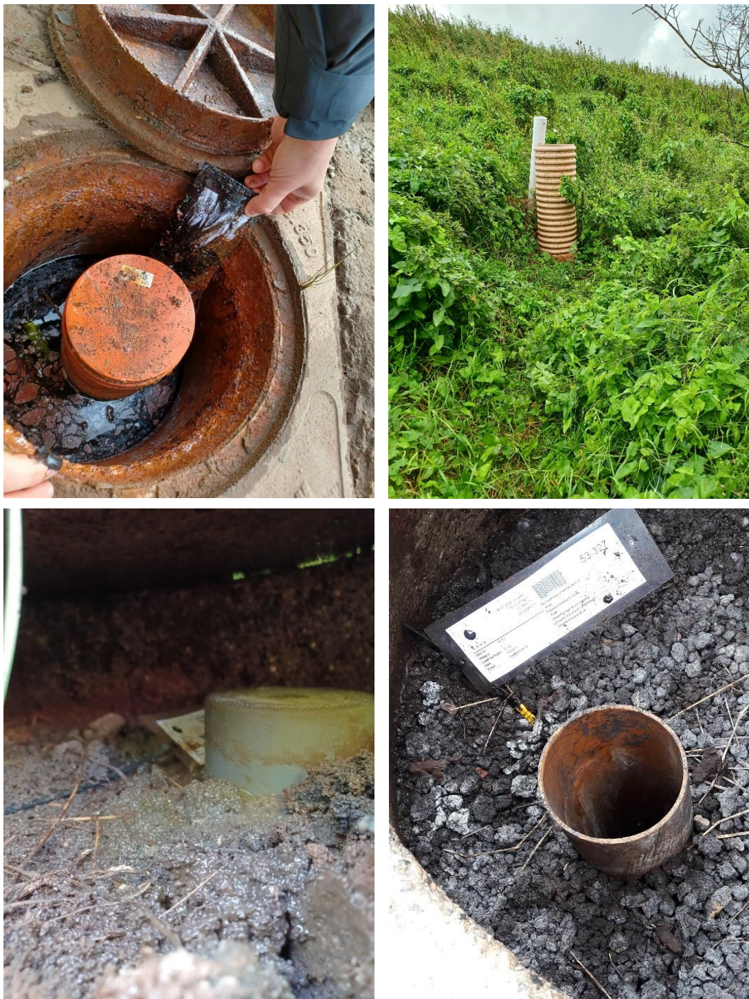
Figur 9. Grundvandsboringerne DGU 53.326 og 53.327. Øverst tv: DGU 53.326 med løftet dæksel. Boringen er placeret på kørearealet ud for den sydlige port til den gamle omlastehal. Øverst th: Grundvandsboring DGU 53.327 ud for aflæsser og omlastehal. Nederst tv: Kig ind i DGU 53.327 på tilsynet. Nederst th: Foto af DGU 53.327 fra 2018.
